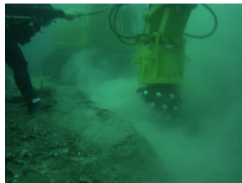
水中切削状況
