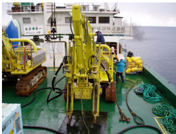
ドリフター水中設置状況
