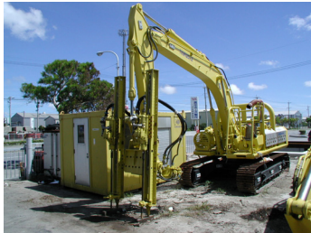
ドリフター機械装着状況
